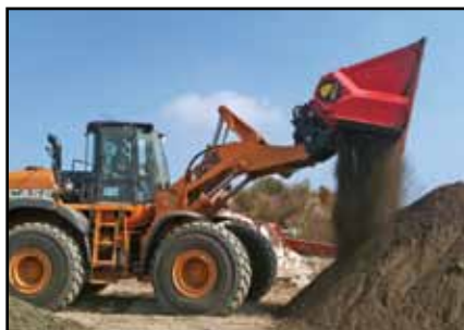
Criblage de terre
