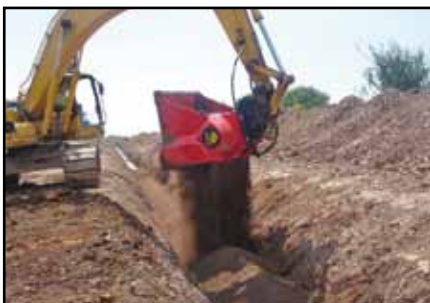
Criblage/Remblaiement de tranchée
