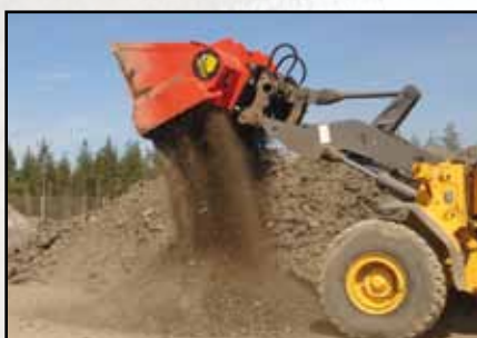
Aération de sols et inertage
